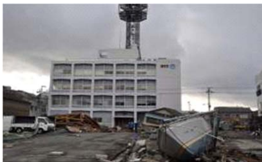
津波により浸水した門脇ビル
