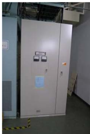
受電設備を3Fに新設
