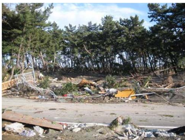
七ヶ浜交換所があった流失跡地
