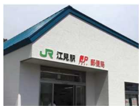
駅舎の 新改築・移設
